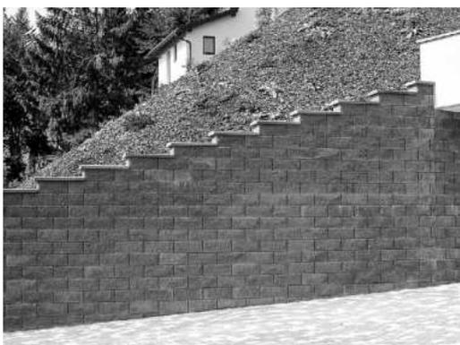
Kreativ Vollwand ist ident wie Kreativ Böschungsstein, jedoch ohne Schub-sicherung an der Oberseite. Dadurch ist die Errichtung von senkrechten Stützwänden mit 30 cm Wandstärke möglich. Fundament und frostbeständiger Füllbeton sowie Armierung sind erforderlich. Als Abdeckung werden Kreativ Mauerabdeckplatten, 50/38/4,5 cm verwendet.
