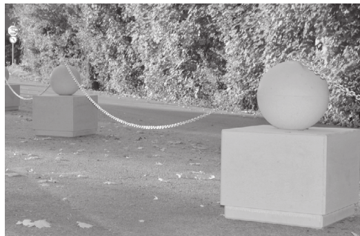
Block Sichtbeton 60/60/50 cm mit Kugel 40 cm und Gewinding zum Spannen einer Kette.
